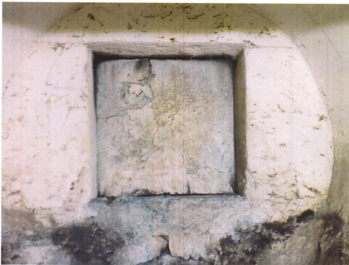
5. Uzupełnienie ubytków w komorze spalania
